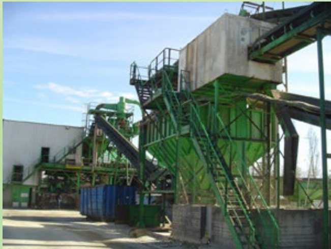
Transformation Usine OI GLASSPACK à Bézier
